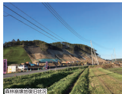
森林崩壊地復旧状況
